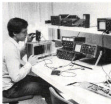
Metingen aan een proefschakeling, opgebouwd uit standaard halfgeleidercomponenten die later worden geïntegreerd in een IC (foto IC Nederland).
